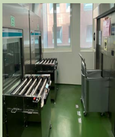
圖一 內藏式垂直軌道運送手術器械醫材系統於手術室運用
